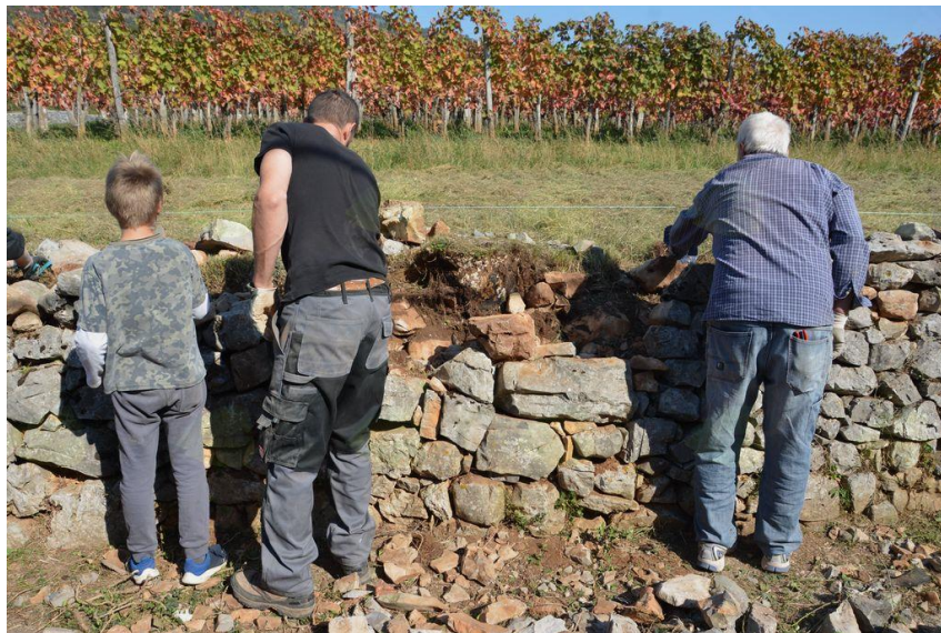
Slika 23: Obnova suhozidanega zidu na Krasu
